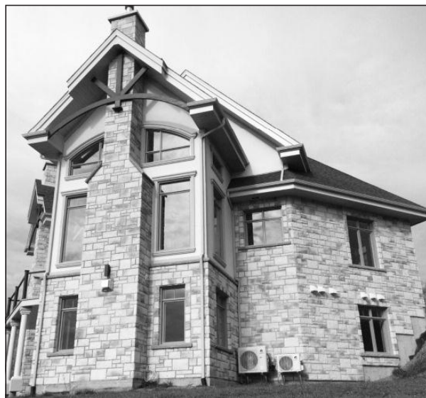
Maçonnerie d'une résidence à Lennoxville
